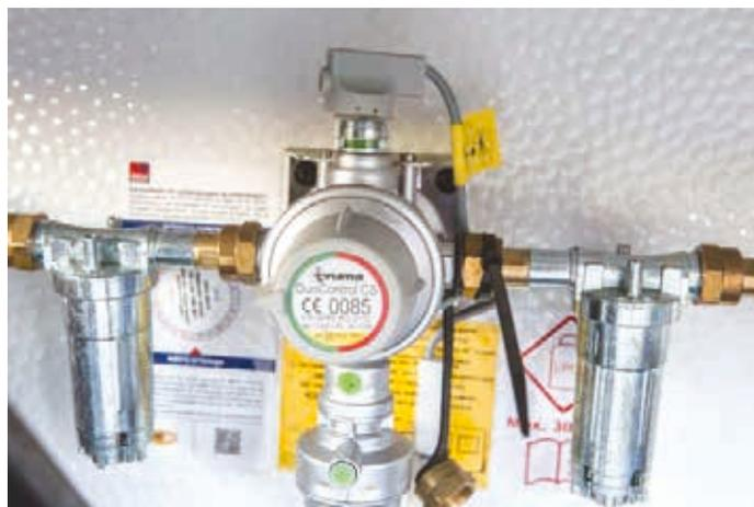
Z.B.: Truma Mono- oder Duocontrol mit Filter und Crashesensor für 1 oder 2 Gasflaschen.
